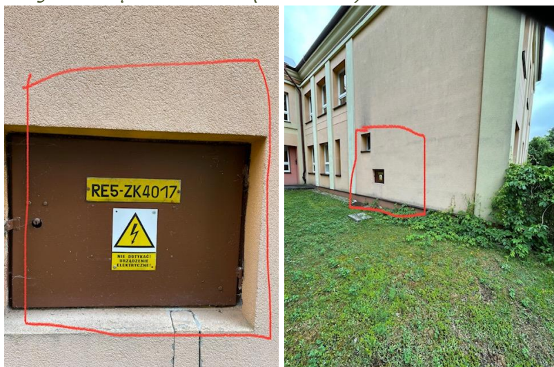
Fotografia 5. Złącze kablowe ZK1 (RE-5-ZK4017)
