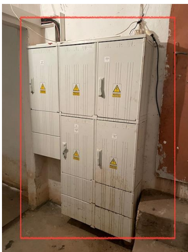
Fotografia 7. Rozdzielnica RZG z podlicznikiem do sali gimnastycznej
