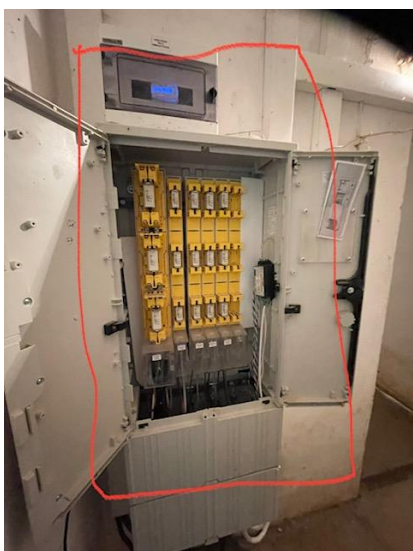
Fotografia 8. Rozdzielnica syreny alarmowej
