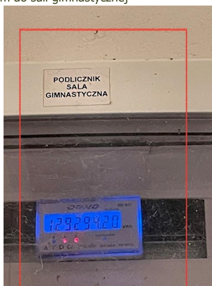
Fotografia 7. Rozdzielnica RZG z podlicznikiem do sali gimnastycznej
