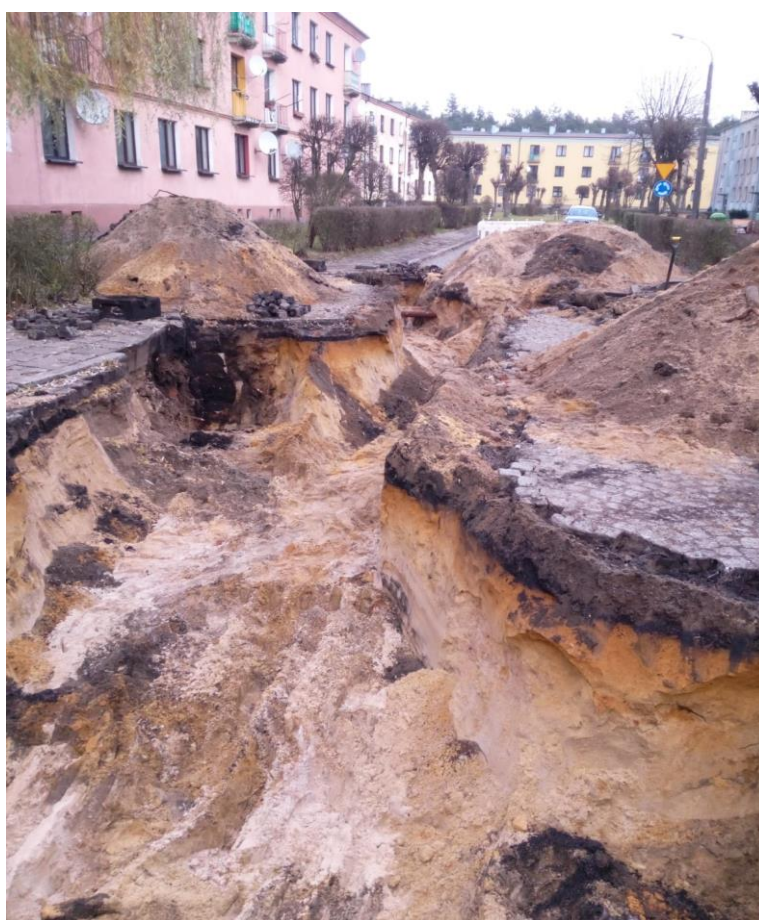
Prace kanalizacyjne w Ziętku
