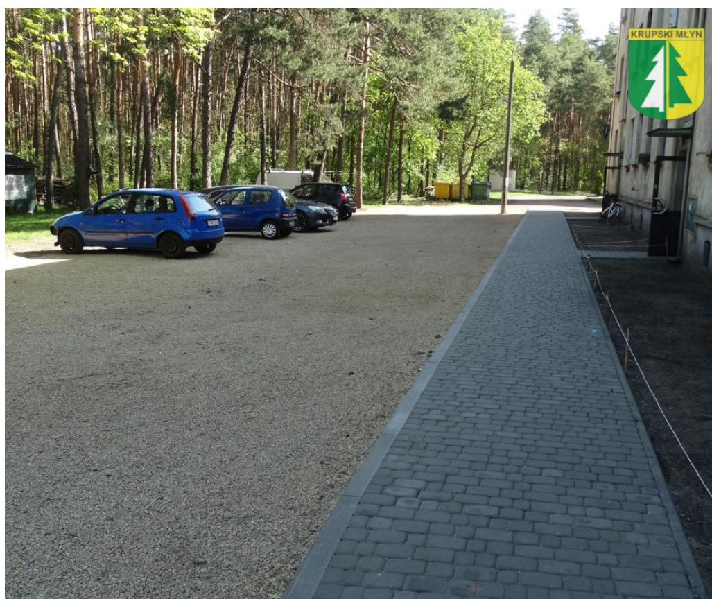
Utwardzenie terenu przed blokiem, budowa chodników, usunięcie płyt betonowych i wykonanie odwodnienia przy bloku nr 5 w Ziętku (zdj. archiwum Urząd Gminy Krupski Młyn)
