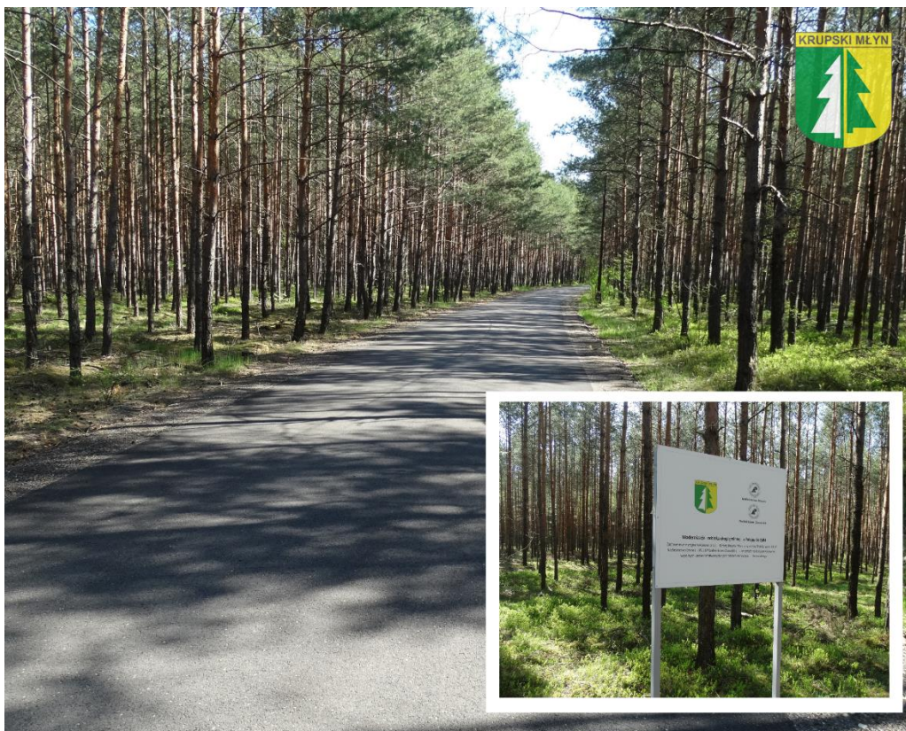
Modernizacja drogi dojazdowej do miejscowości Żyłka (zdj. archiwum Urząd Gminy Krupski Młyn)
