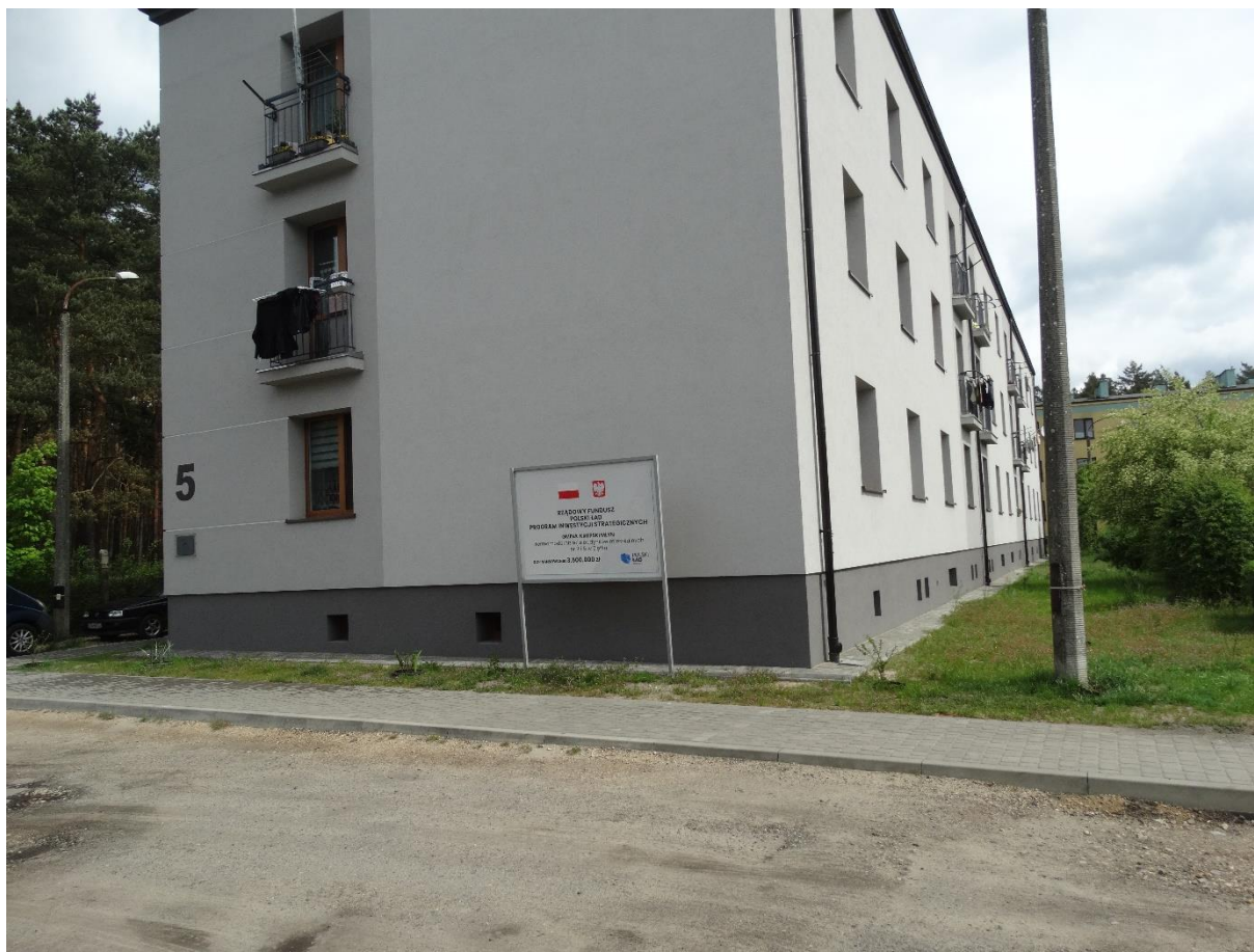
„Termomodernizacja budynków mieszkalnych nr 3 i 5 w Ziętku (zdj. archiwum Urząd Gminy Krupski Młyn)
