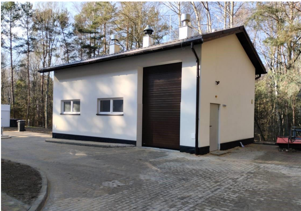
„Ochrona dorzecza Małej Panwi poprzez rozbudowę i modernizację gospodarki wodno-ściekowej – etap II – realizacja projektu na terenie Gminy Krupski Młyn” (zdj. archiwum Urząd Gminy Krupski Młyn)
