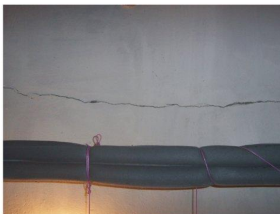
SPEKANA PŁYTA STROPOWA NAD POMIESZCZENIEM BYŁEJ KOTŁOWNI
