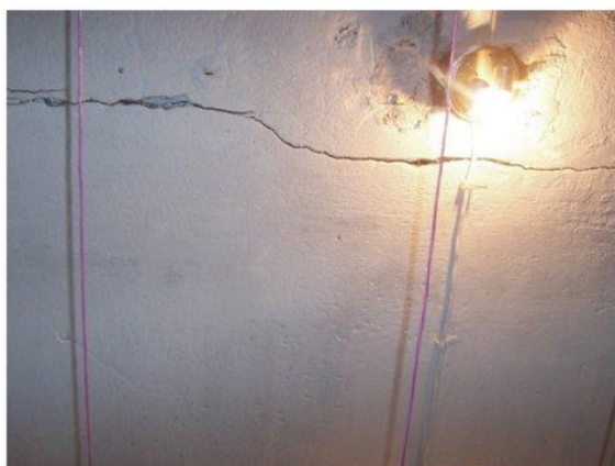
SPEKANA PŁYTA STROPOWA NAD POMIESZCZENIEM BYŁEJ KOTŁOWNI
